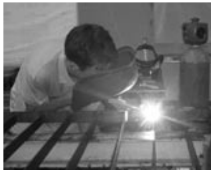
Michael, apprenti en construction métallique
