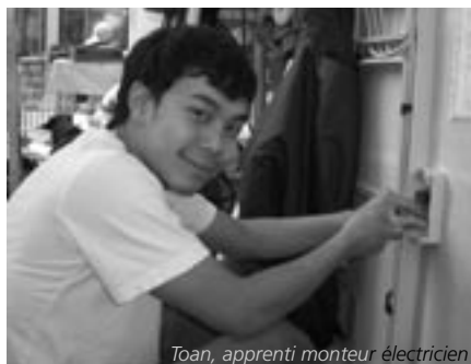
Toan, apprenti monteur électricien
